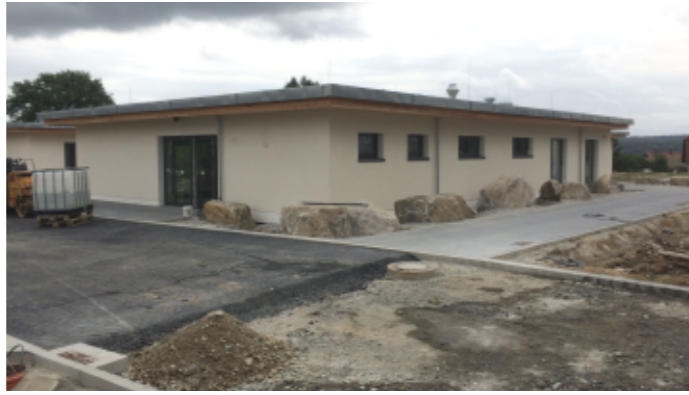
Der Fortschritt bei den Außenanlagen ist deutlich zu erkennen. Auch der Innenausbau ist so gut wie abgeschlossen.
